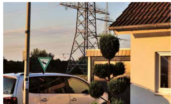
Strommasten in direkter Nähe zur Wohnbebauung von Geyen – Amprion will sie auch für Ultranetleitungen nutzen.
