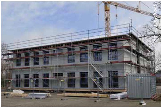
Der Erweiterungsbau am Geschwister-Scholl-Gymnasium nimmt Gestalt an.
